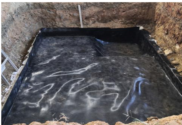
废机油罐池防渗处理
