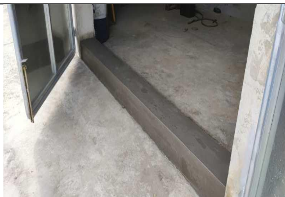
危废暂存间围堰
