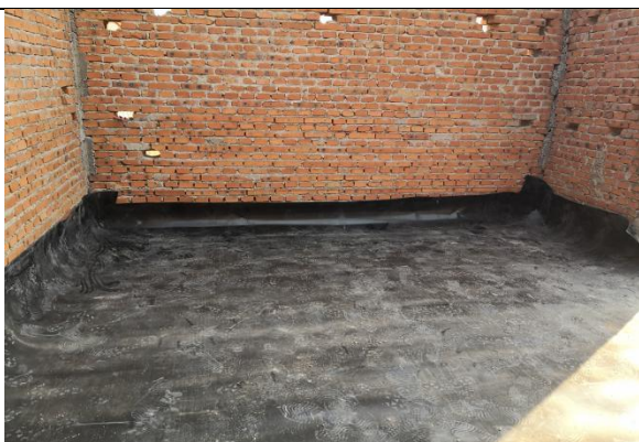
危废暂存间防渗处理
