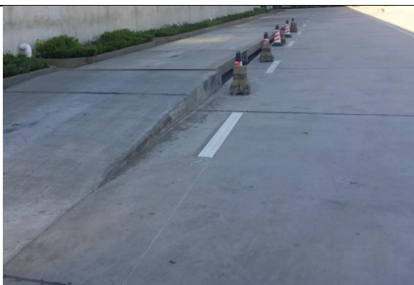
厂区道路硬化
